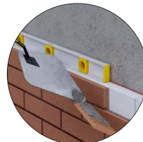
3 Aplicación de adhesivo en fachaletas
